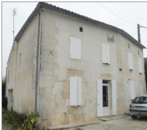
Maison à étage surmonté de combles dans le hameau de Chez Pierrot
