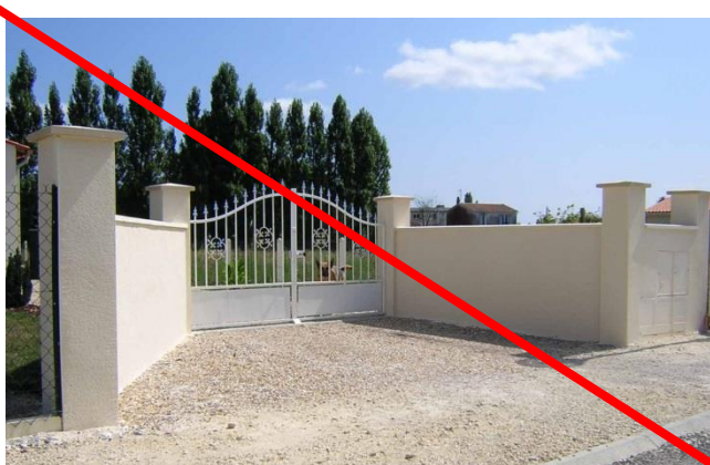
Piliers de portail en maçonneries imposantes sans lien avec la clôture (grillage).
